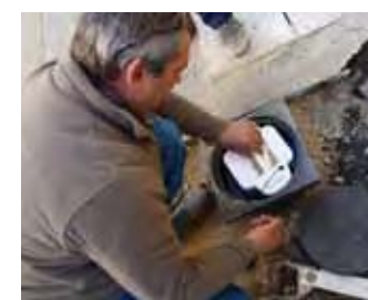
Rénovation des branchements d'eau
